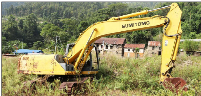
नेपाल पूर्वाधार विकास कम्पनी लिमिटेडले निर्माण गर्ने भनिएको हेटौडा-भीमफेदी-काठमाडौं सुरुङ्गमार्गको उद्गम स्थल भीमफेदी गाउँपालिका-२ बजार नजिक रहेको खहरे खोलामा थन्किएको एक्साभेटर ।
