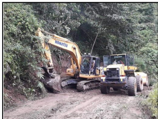
भीमफेदी गाउँपालिका वडा नम्बर ८ मा बन्ने अखिल नेपाल खेलकूद महासंघको स्थायी कार्यालयको निर्माण कार्य अग्रेसरमा अगाडि बढेको छ।
