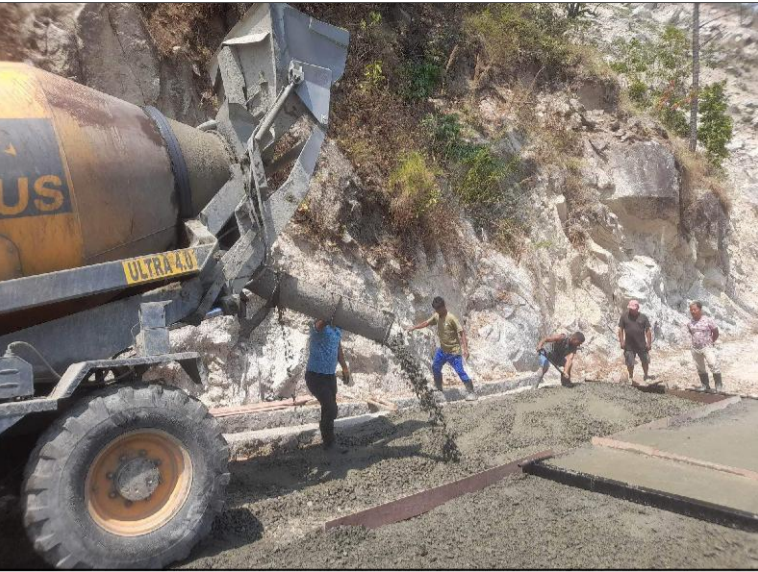
भीमफेदी गाउँपालिका-८ देउराली-ईषा सडक छण्डमा भइरहेको स्याव ढलान कार्य । संघीय र प्रदेश सरकारसमेतको १० करोडको लगानीमा ३ प्याकेजमा ढेक्का लगाएर स्याव ढलान निर्माण भइरहेको हो । सडक स्तरोन्नति र ३ किलोमिटर स्याव ढलान चालू आर्थिक वर्षको आसारमसान्त सम्पन्न गरिसक्ने लक्ष्य लिइएको गाउँपालिका अध्यक्ष हिदम लामाले जानकारी दिए ।
